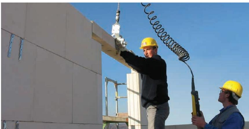
Bild 16: Einbau eines KS-Flachsturzes mit Versetzhilfe.
