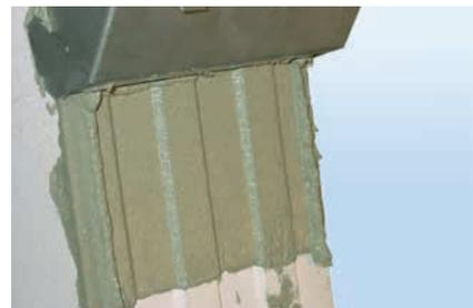
Bild 18: Stoßfugenvermörtelung mit einer geeigneten Stoßfugenkelle.
