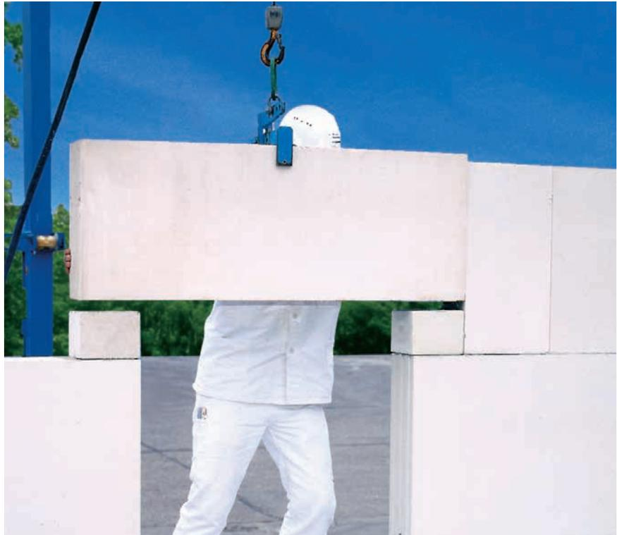
Bild 22: Einbau eines KS-Fertigteilsturzes (FTS) nach abZ Z-17.1-621.
