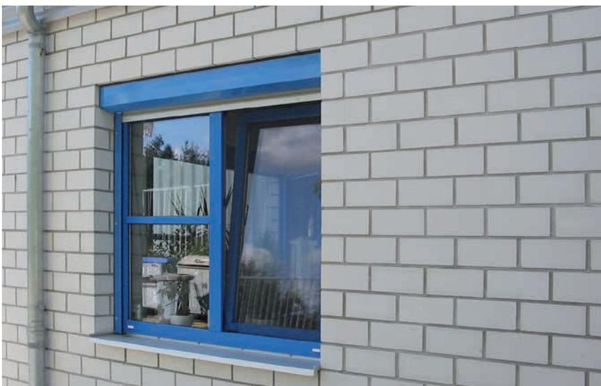
Bild 26: Fassade und KS-Sichtmauersturz bilden eine ästhetische Einheit.
