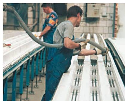
Bild 12: Verfüllen der KS-Sturz-Schalen.
