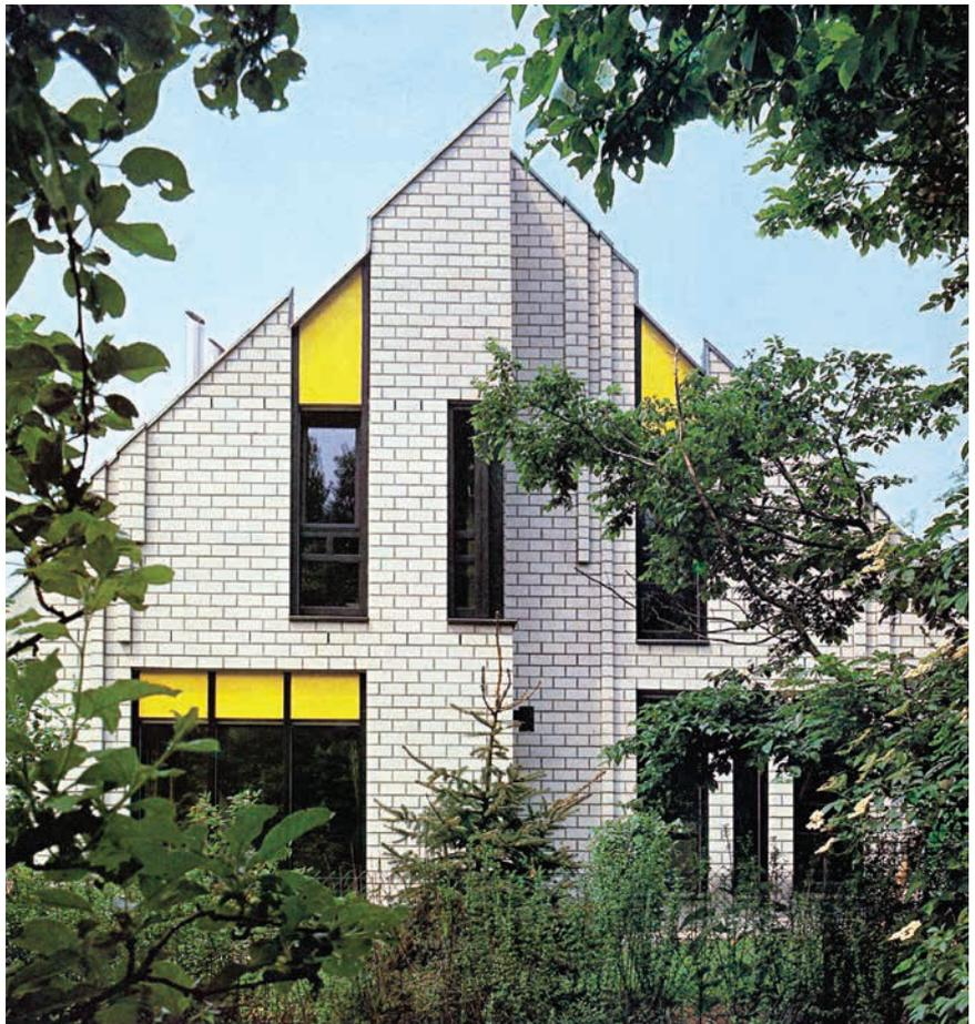
Bild 1: KS-Sichtmauerwerk-Fassade mit eingebauten KS-Sichtmauerstürzen.
