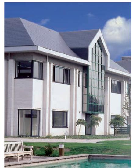
Bild 27: Fassade aus KS-Sichtmauerwerk.
